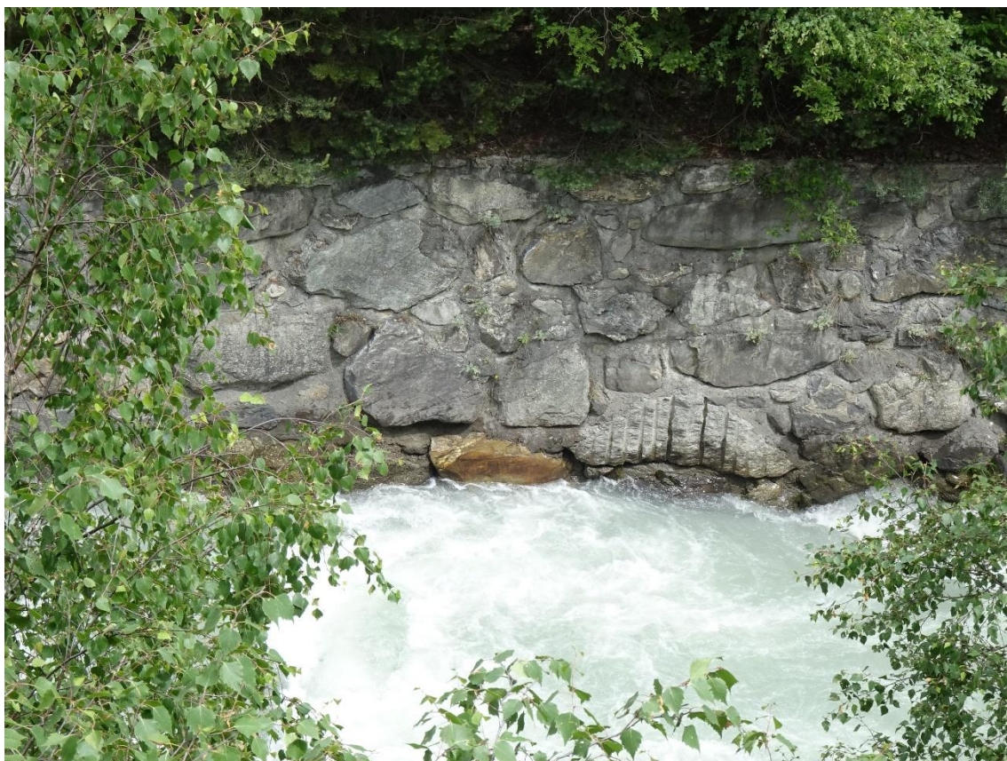
Figura 4-21: dettaglio della scogliera artificiale a rinforzo del piede della sponda sinistra
